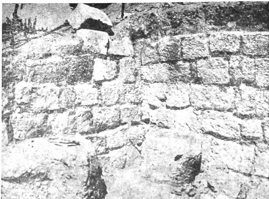
Fig. 25. — Blidarul. Interiorul Turnului VI. Colțul nord-estic.
